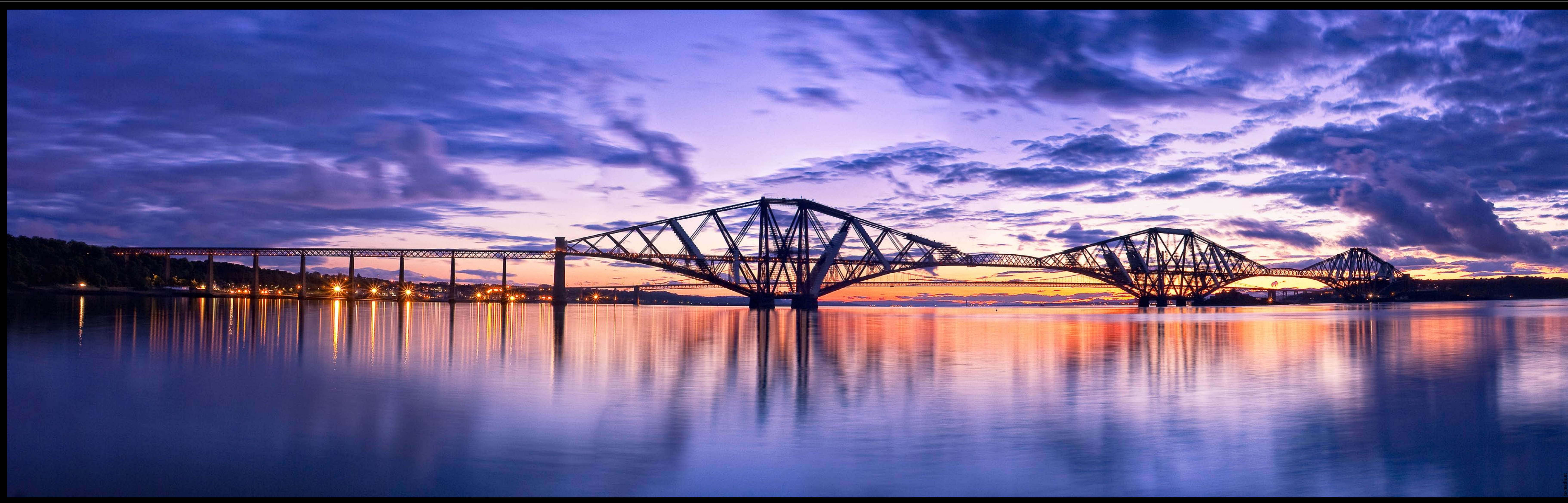
» Forth Bridge, erbaut 1890 – South Queensferry, Schottland «
